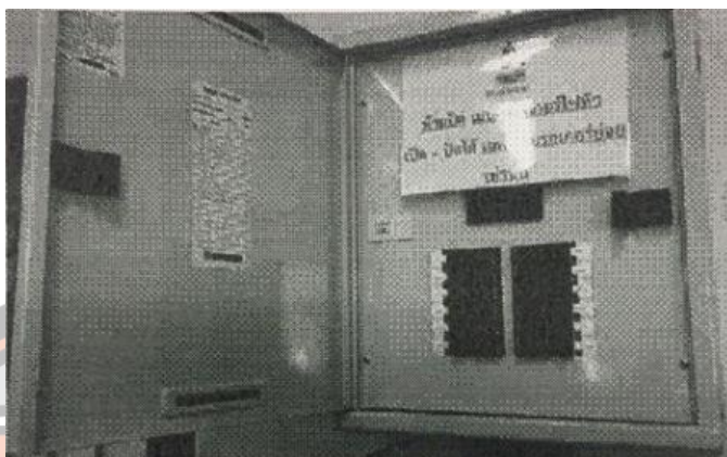
ภาพที่ 2 แสดงเมนสวิตช์ (Main Switch)
