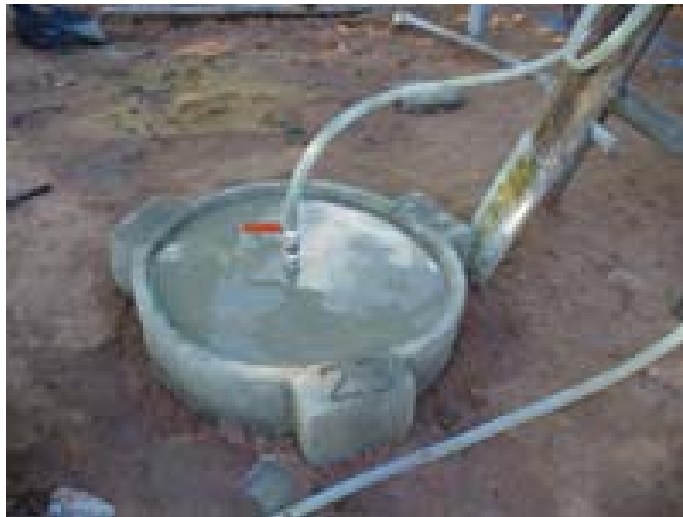
ภาพที่ 2 การต่อท่อก๊าซ
